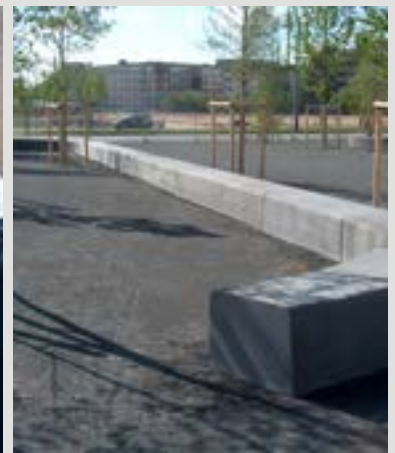
Der neu gestaltete Hafenbereich der Hansestadt Bremen wurde nachhaltig geschützt mit Fluorosil Classic.
