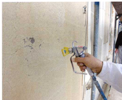
An der Fassade wurde der Abbeizer mithilfe eines Airless-Geräts rationell aufgebracht.
