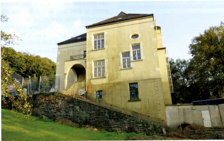
Das schöne, historische Volksschulgebäude in Remscheid (Nordrhein-Westfalen) wurde vor dem Abriss bewahrt und wird nun von Grund auf restauriert.
