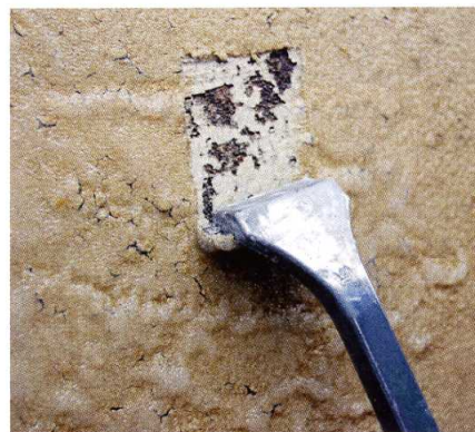
Nach der Einwirkzeit lässt sich der Abbeizer mit der Farbschicht abschieben.
