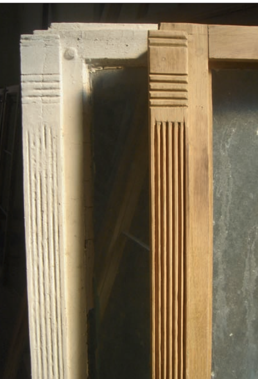
Vollständig entlacktes und nachgereinigtes Holzfenster
