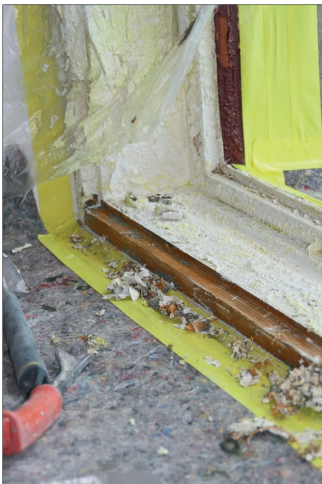
Abbeizen eines Fensterstockes mit Asur-Entlacker. Die vollständige Entfernung der gelösten Lackschicht erfolgt mittels Ziehklängen.
