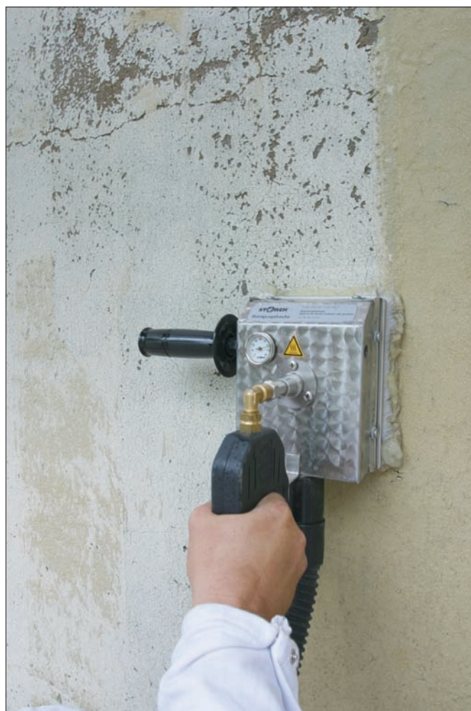
Abbeizvorgang mit einer Storch-Hochdruckkrake.
