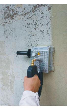
Nach zweimaligem Auftrag eines CKW-freien Abbeizers und anschliessendem Abkratzen werden die letzten Reste der Dispersion mit einer Hochdruck-Krake heruntergewaschen.
