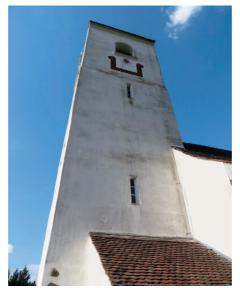
Die romanische Pfarrkirche in Ammerswil entstand vor 1300, der Turm ist aus dem 15. Jahrhundert. Er wurde 1886 mit einem abgeriebenen Kalkputz versehen. In den 1970er-Jahren wurden entstandene Riss mit Kunststoffspachtel saniert und eine Armierungsdispersion aufgetragen.
