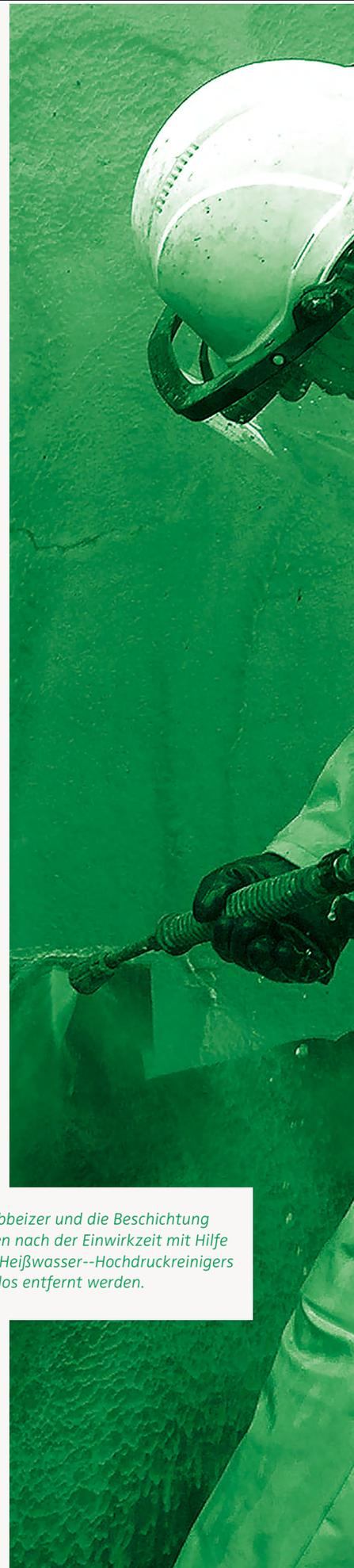
Der Abbeizer und die Beschichtung können nach der Einwirkzeit mit Hilfe eines Heißwasser-Hochdruckreinigers mühelos entfernt werden.
