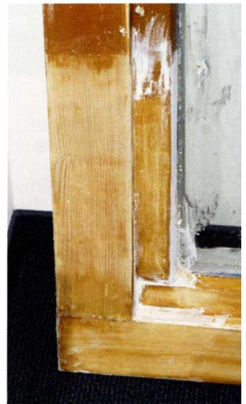
Abbeizmittel sind eine etablierte Methode zur Anstrichentfernung. Aber die Zeit der Dichlormethan-haltigen Produkte läuft jetzt ab!
