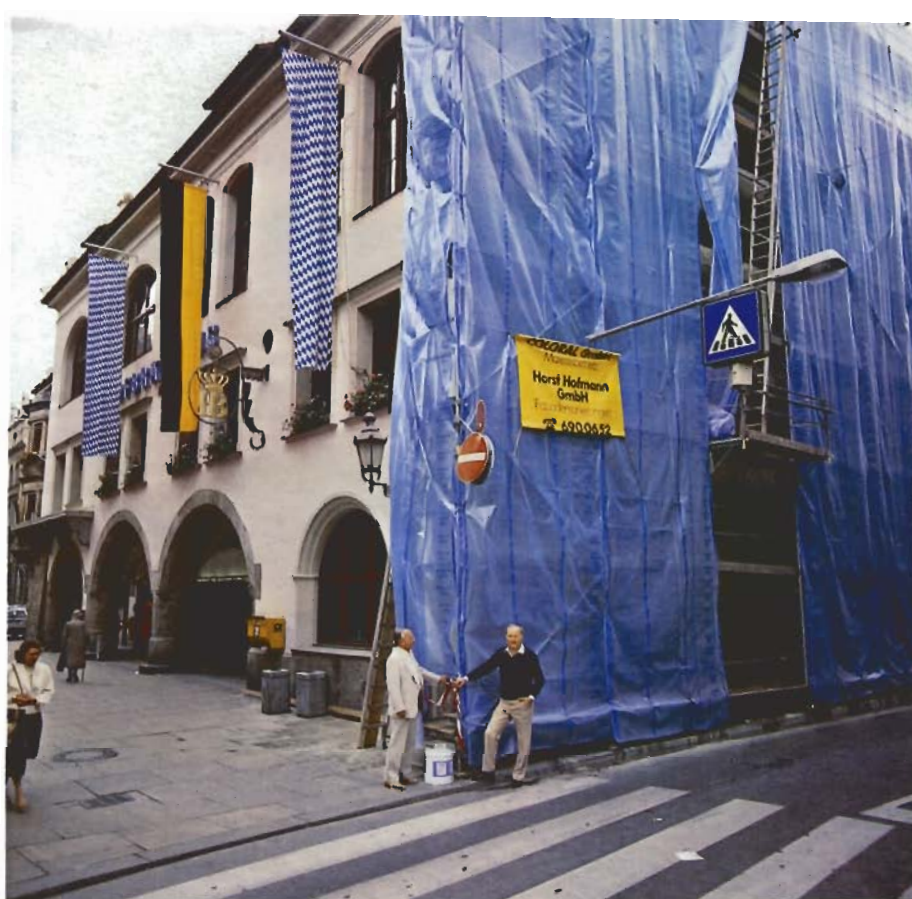
Reines Bier bedingt reine Luft und reines Wasser! Daher forderte das Ingenieurbüro Kienast und Hohler, ein umweltfreundliches Abbeizmittel für das weltberühmte Hofbräuhaus in München am Platzl. (Werkfoto: Scheidel GmbH)
