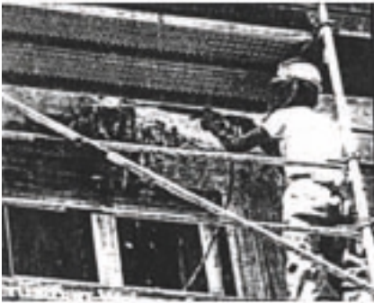
Auftragen des Abbeizers mit dem Airlessgerät
