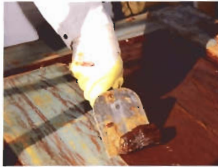
Mühe los: Abschieben der Farbschichten
