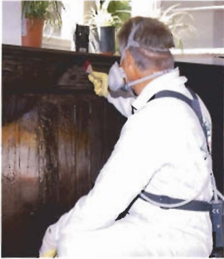
Testort Holzverkleidung: Rudolf Lehmkuhl trägt den CKW-freien Abbeizer auf
