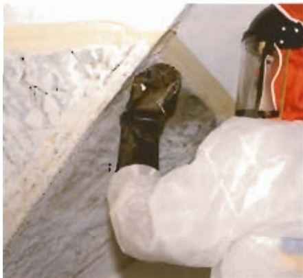
Christian Raus kämpft mit dem dichlormethan-haltigen Abbeizer. Links im Bild: nach einmaligem Abbeizerauftrag entschichtete Fläche
