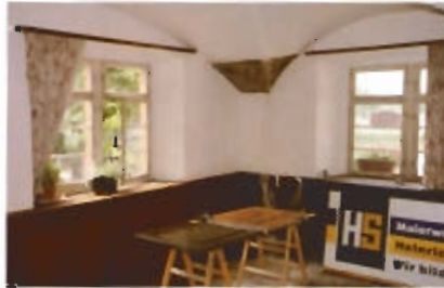
Der Raum, in dem die Abbeizarbeiten durch- geführt wurden
