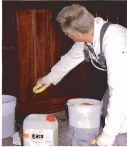
Nachbehandlung der Fläche mit Powerfluid- Reinigungslösung
