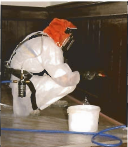
Christian Raus trägt den dichlormethanhaltigen Ab- beizer auf die Sockelfläche auf
