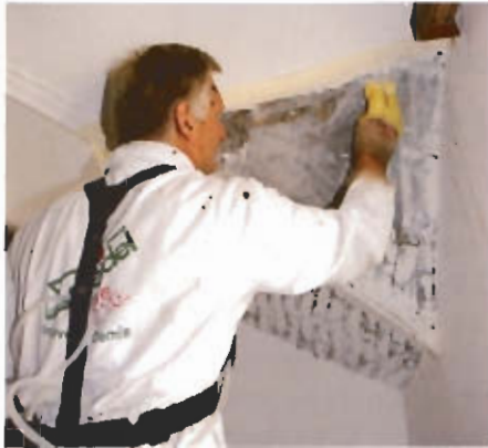
An der Decke: Rudolf Lehmkuhl trägt den CKW-freien Abbeizer auf
