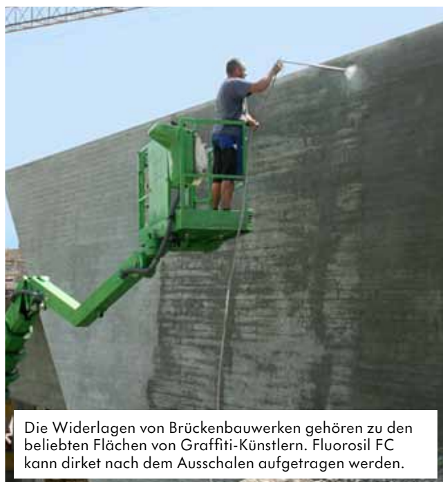
Der Architekturbeton der Fa. Dressler Bau (Aschaffenburg) wurde mit Fluorosil FC geschützt. Der ideale Schutz für den Transportweg und den dauerhaften Objektschutz
