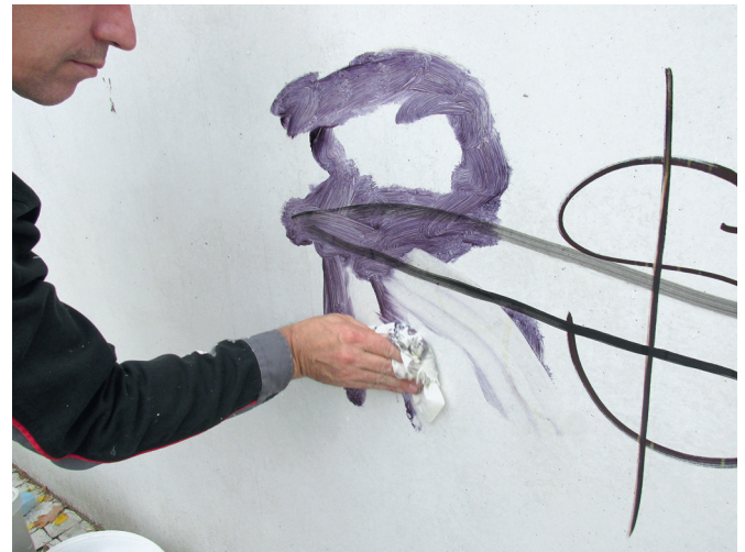
Graffitentfernung von geschützter Fläche – Foto: Scheidel
