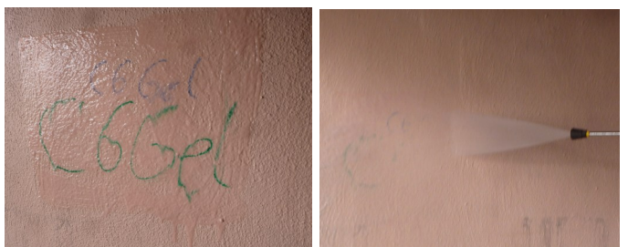
Graffiti-entfernung C6 Gel Graffiti-entferner Oberfläche mit einem Kaltwasser-Hochdruckreiniger, ca. 80bar, reinigen
