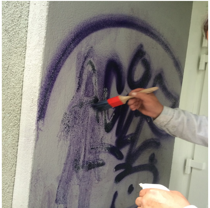
Graffiti-entfernung HydroPurSilan® gewährleistet stets eine einfache und zuverlässige Graffiti-entfernung, in diesem Fall mit Scheidel Liquid Graffiti-entferner
