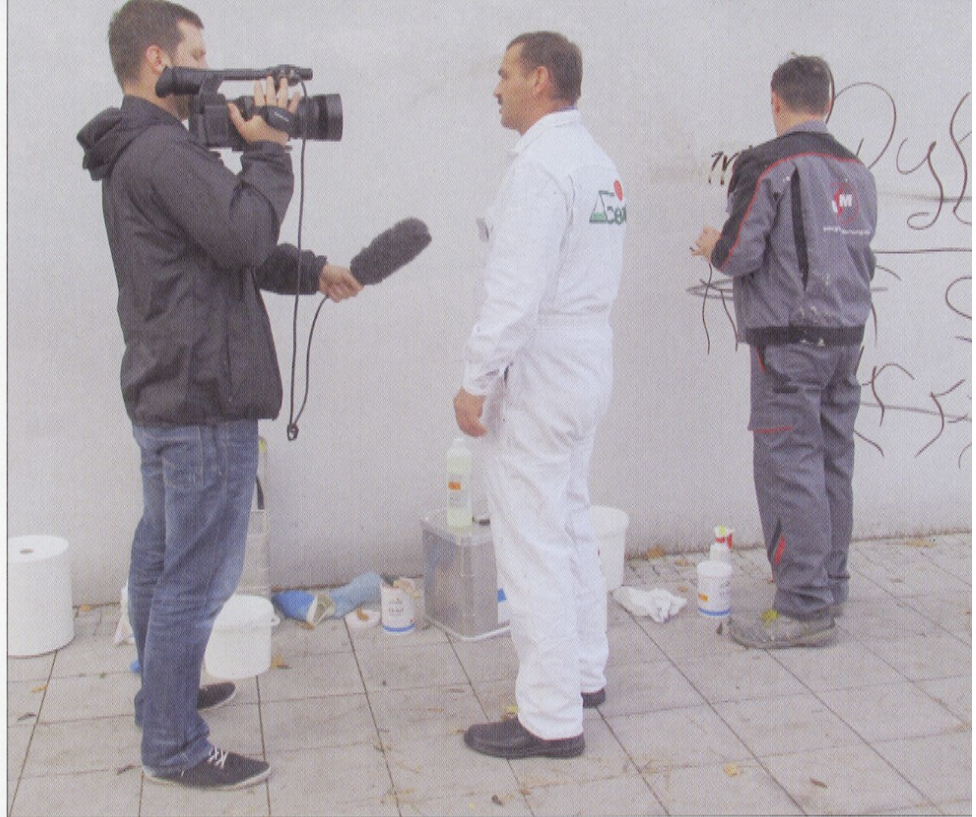
Der eingesetzte Graffitireiniger löst die Beschmierungen der Faserschreiber sanft von der imprägnierten Wandfläche.
