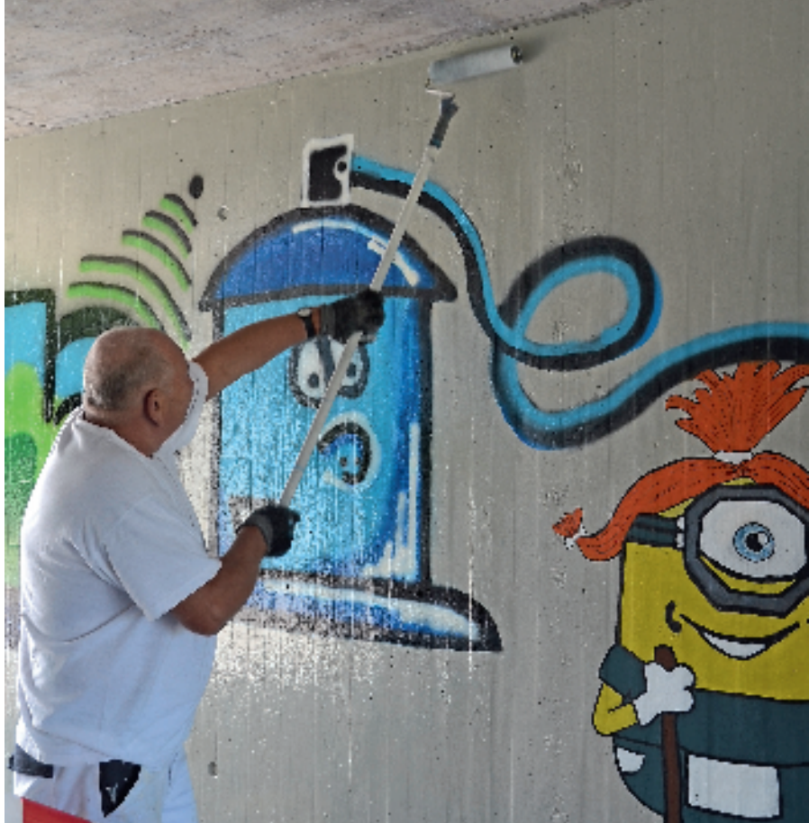
Diese Unterführung wurde von Kindern bemalt. Damit die Kunstwerke vor Schmierereien geschützt sind, erfolgte anschließend eine Beschichtung mit einem Schutzlack auf Epoxy-Basis.
