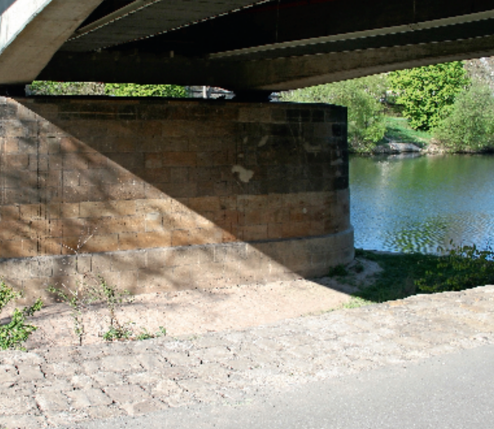
Derselbe Brückenpfeiler, auf dem vor kurzem noch „Hanna ich liebe dich“ zu lesen war, nach der Graffiti-Entfernung und einer Anti-Graffiti-Imprägnierung, die die Entfernung neuer Sprayer-Attacken erleichtern soll.
